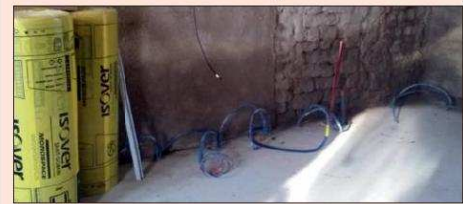
La rénovation énergétique de l'habitat doit s'attacher à utiliser des matériaux labellisés comme non-émissifs de polluants, tels les isolants bio sourcés.
