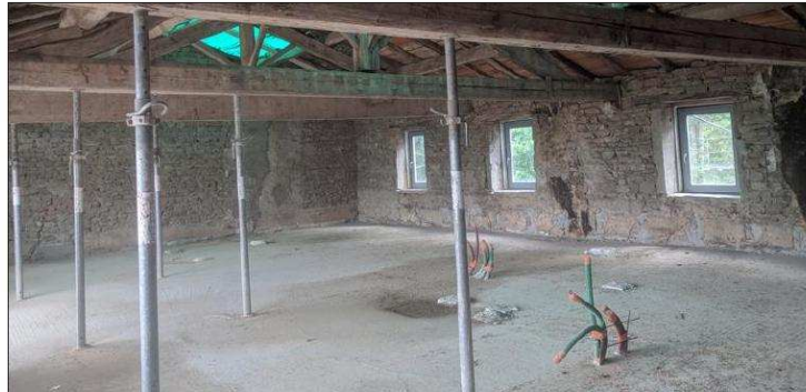
Le chantier de réhabilitation de l'ancienne gendarmerie intègre la problématique de la santé dans l'habitat, et notamment le risque radon. Photo DR/Fournie par Michel MAYA
